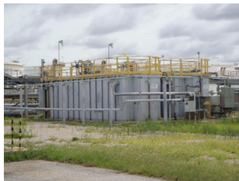
ระบบบำบัดน้ำเสียจากอาคารสำนักงาน (Sanitary System)
